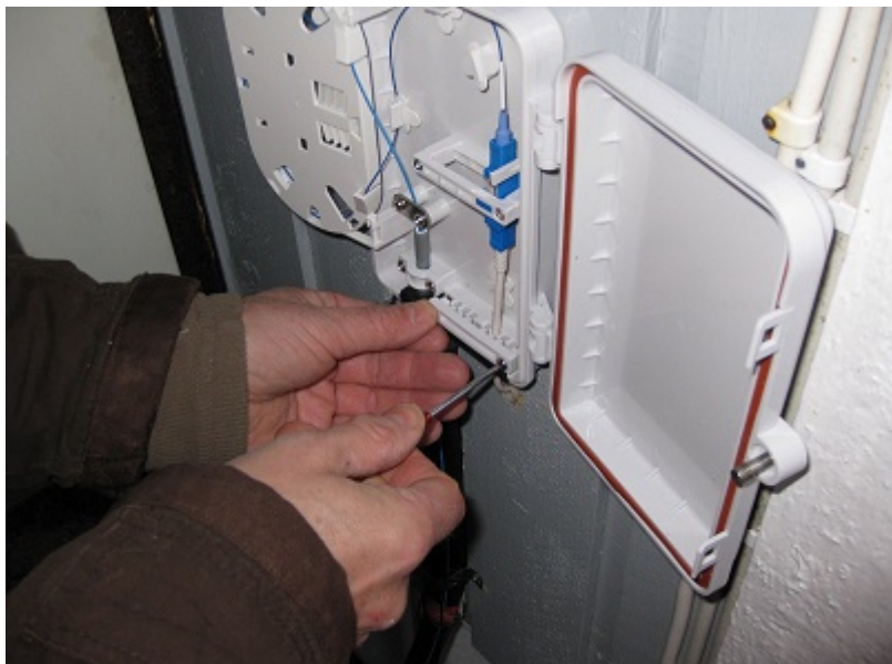
Montera dragavlastningen. Den skall inte dragas åt hårt.
