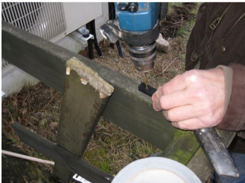
Borra ett 3 mm hål i gummitätningen.
