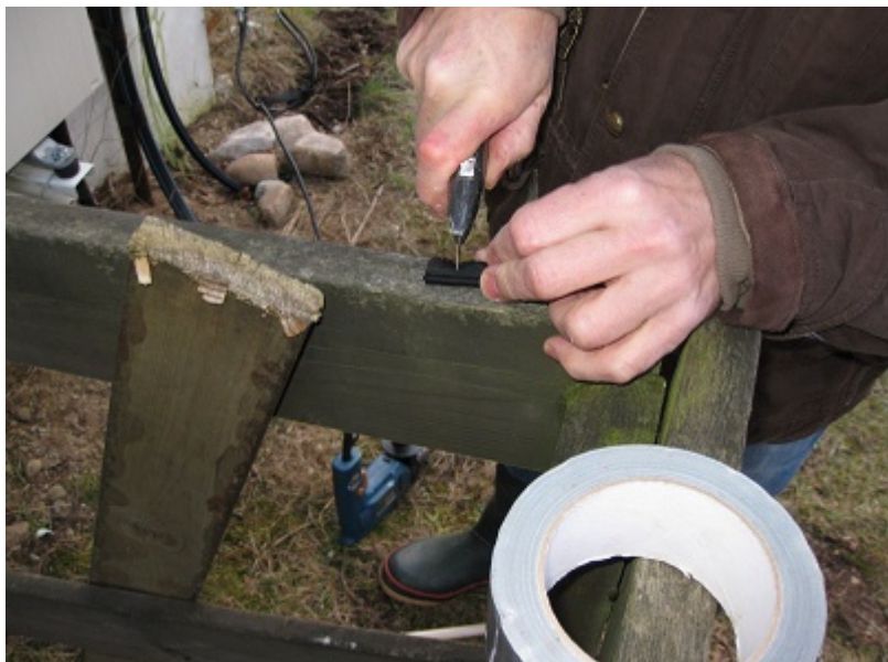
Skär med en vass kniv igenom gummitätningen från hålet till kanten av tätningen.
