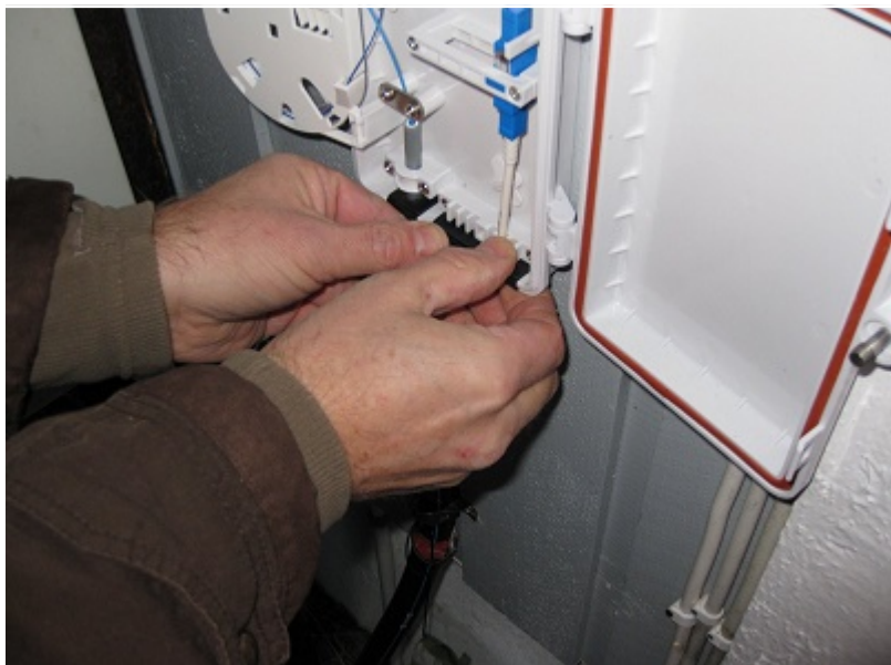
Montera tillbaka gummitätningen.
