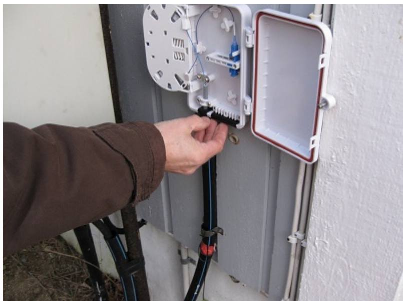
Tag bort gummitätningen.
